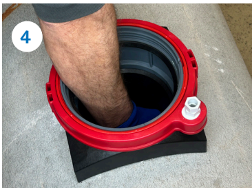
Insérer le raccord jusqu'à la butée.
