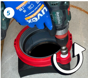
Anschluss mit dem Akkuschauber schnell und einfach anziehen
