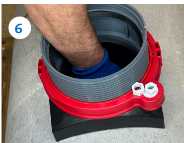
Desserrer et retirer la tige de poussée
