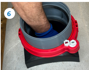
Hebel poprzeczny ukrócić i wyjąć
