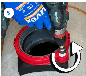
errer rapidement et facilement à l'aide d'une visseuse sans fil
